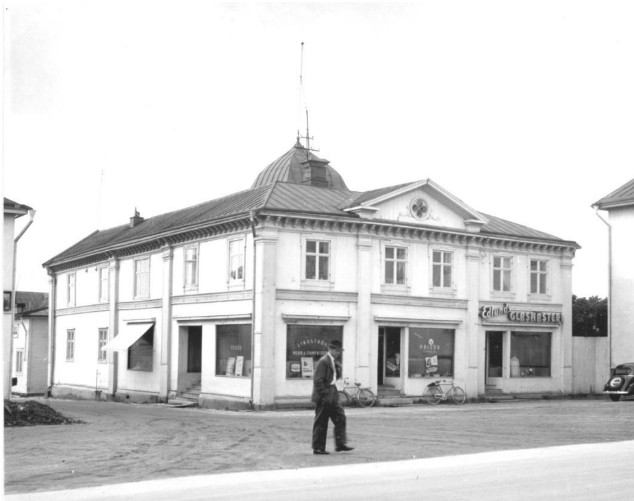
Falken 8 med träfasaden bevarad, men med stora skyltfönster. Piteå museums bildarkiv.
