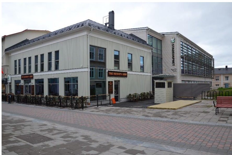
Vid byggandet av det så kallade Kaleidohuset anpassades huskroppen närmast Storgatan till trästadens skala och volym. Foto Catharina Westling, Piteå museum.
