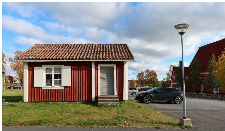
En bevarad kyrkstuga står idag intill kyrkan i Kalix. Foto: Sophie Nyblom, 2022.
