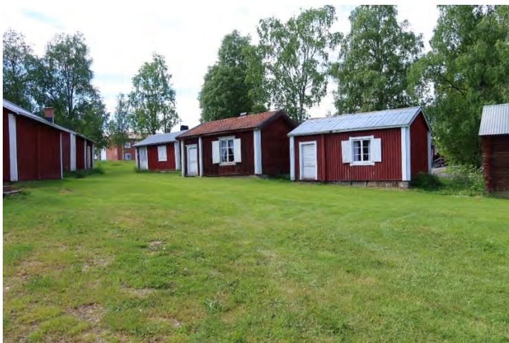
Kyrkstugorna i Råneå har olika behov av upprustning. Foto: Sophie Nyblom, 2022.
