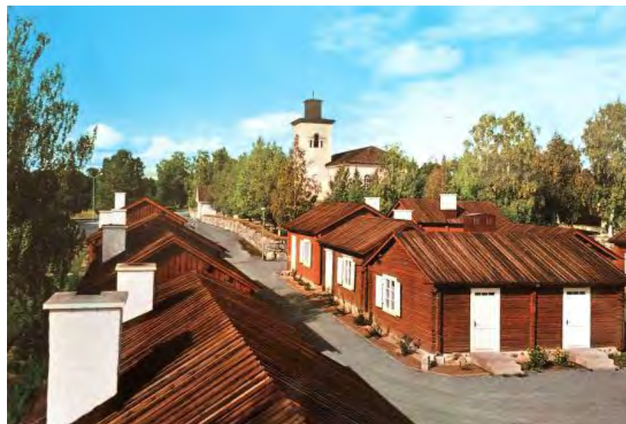
Övertuleå kyrka och kyrkbyn efter upprustningen av stugorna och Kläppenrådet på 1960-talet. Både fasader och brädtak är rödfärgade och skorstenarna hade murats om. Bilden lånad från Svenska kyrkans hemsida. 11
