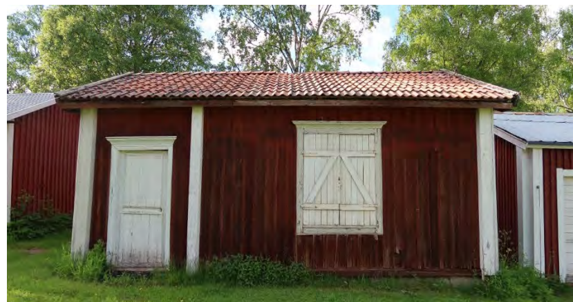
Stugorna i kyrkstäderna är ofta i behov av olika åtgärder. Vissa behöver kanske se över taket och skorstenen medan andra behöver åtgärda dörrar och fönsterluckor med flagnande färg eller en panel där falurödfärgen endast skimtar i sprickorna. Den här stugan finns i Råneå kyrkstad. Foto: Sophie Nyblom, Piteå museum 2022.
