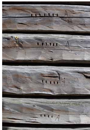
Byggnaden som kunskapskälla. Spår av timmermännens verktyg syns tydligt i de nakna timmerstommarna. Uppmärkta stockar berättar att stugan är flyttad. Kyrkstuga 181
