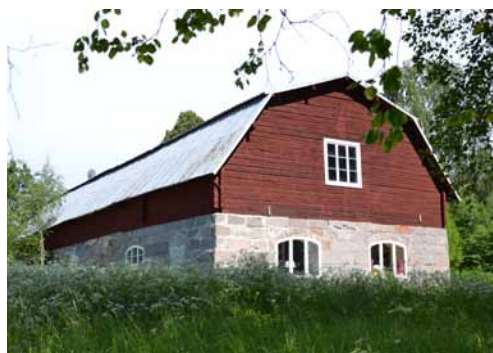
I norra delområdet finns några av Öjebyns största och mest välbevarade ekonomibyggnader. Här syns stor stenladugård från tidigt 1900-tal. Öjebyn 28:22
