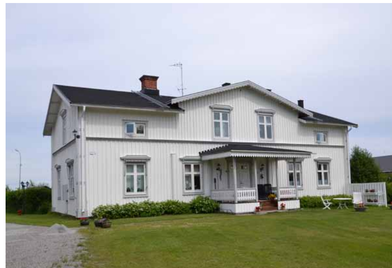
Den stora träbyggnaden uppförd 1865 har en viktig relation till Kustlandsvägen eftersom det under en period fungerade som gästgiveri. Öjebyn 31:15
