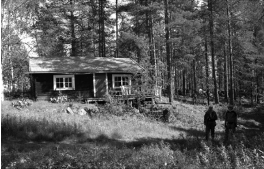
Den ombyggda fäbodstugan vid Lidbodarna. Foto Åsa Lindgren © Norrbottens museum.
