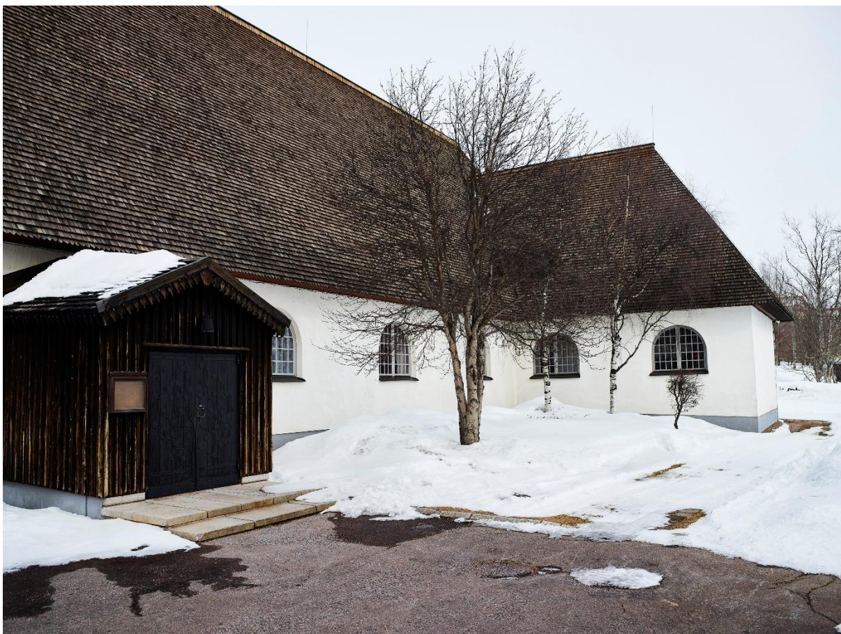
Exteriör från söder, med vapenhuset till vänster och sidoskeppet till höger.
