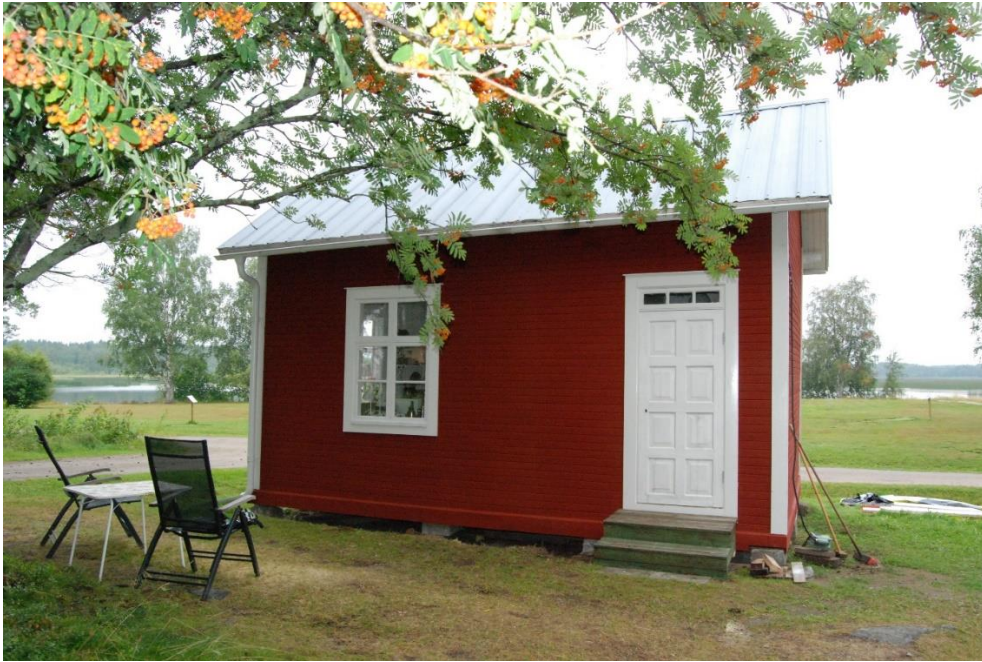
Kyrkstuga nr 19 i Norrfjärdens kyrkstad är en av de stugor som har renoverats under sommaren. Foto Anna Elmén Berg.
