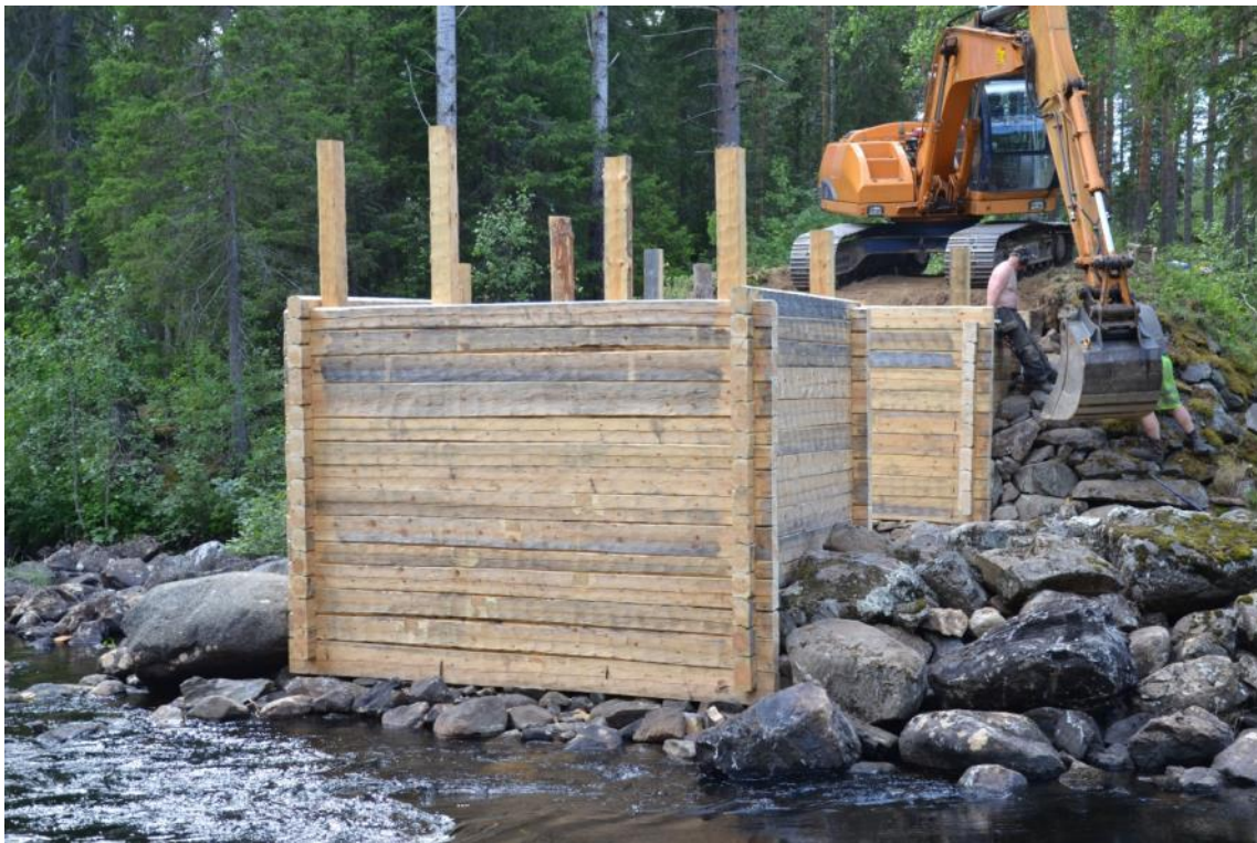
Efter upptimringen av de nya kistorna återställs stenkorna mot kistornas sidor, vid landfästen och mellanstöd. Foto: 2011
