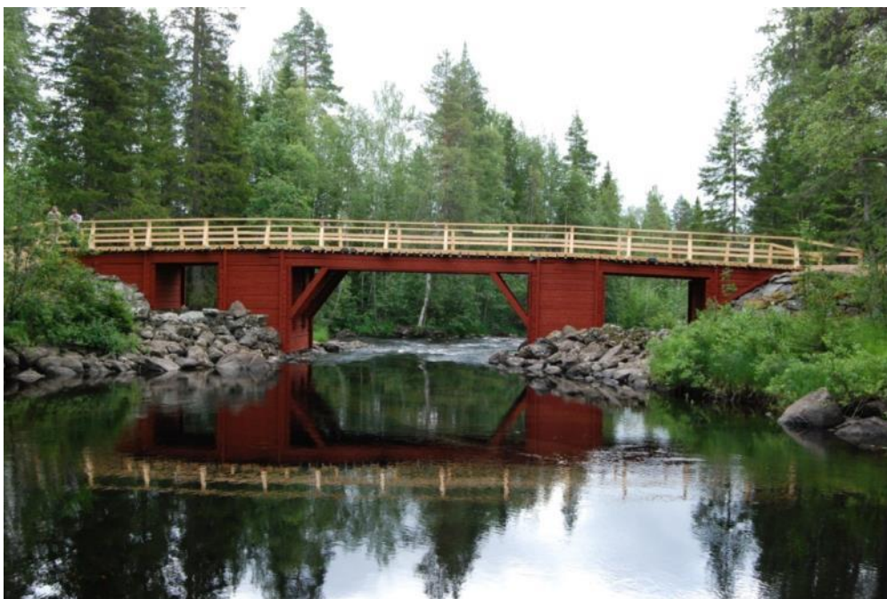
Sågforsbron efter rekonstruering. Hela brokonstruktionen utom brobana och räcke är målad med röd slamfärg. Foto: 2012
