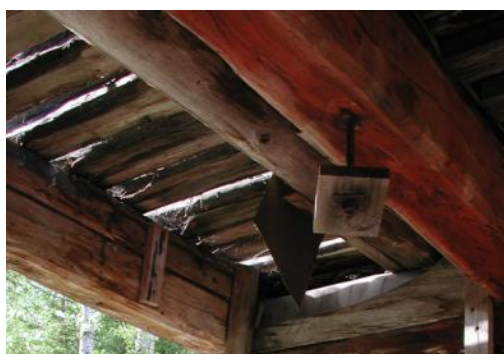
Tv: Större delen av brokonstruktionen var kraftigt angripen av röta Foto: 2011
